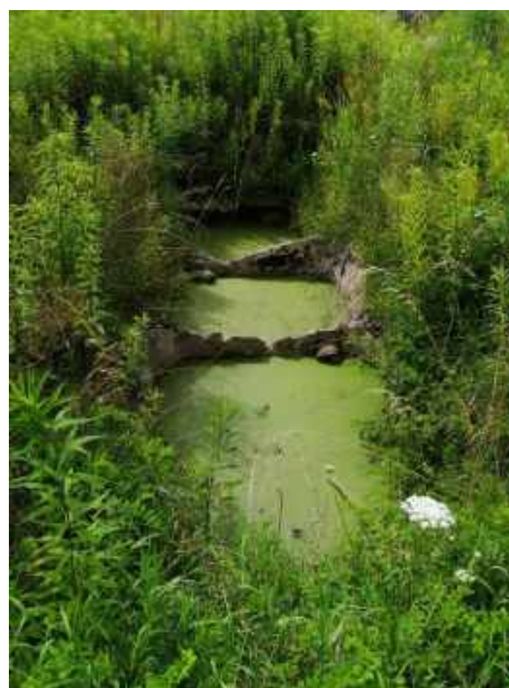
Obecny (2020 r.) stan zachowania dawnej infrastruktury stacji paliw – zbiorników podziemnych
