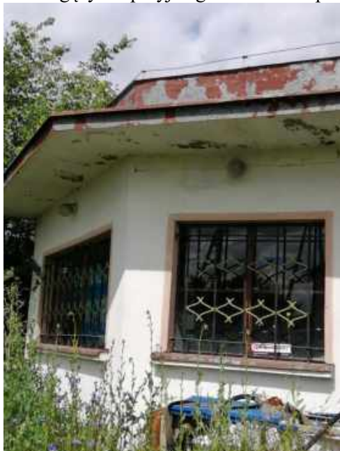
Szczelne otwory okienne, obróbki blacharskie i ściany zewnętrzne bez ubytków
